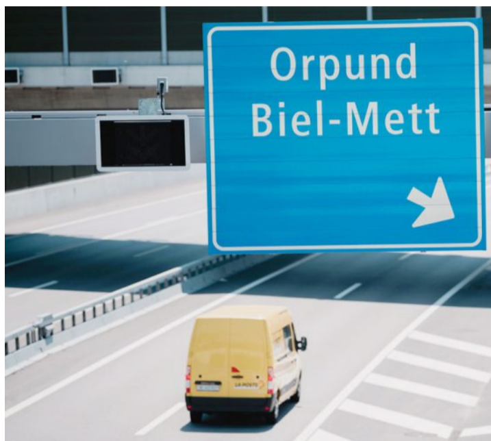
Sollen bald ergänzt werden: Die Ortsangaben auf der Beschilderung für den A5-Ostast. MATTHIAS KÄSER
