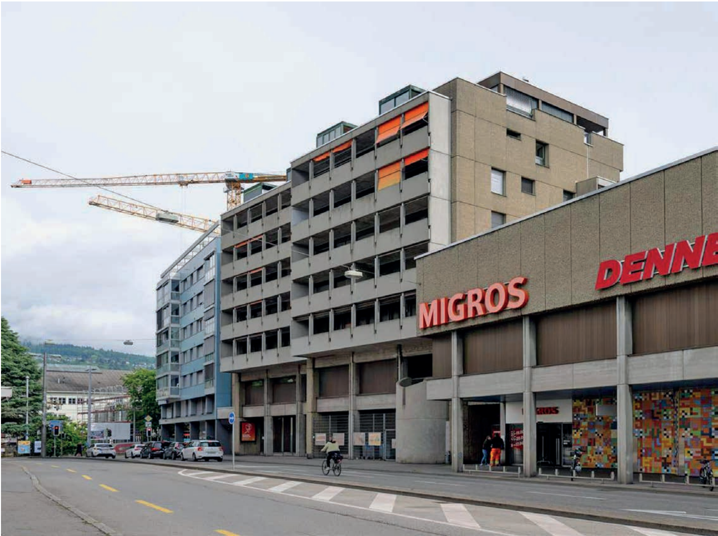
Le bâtiment, construit en 1979, va être remplacé.
