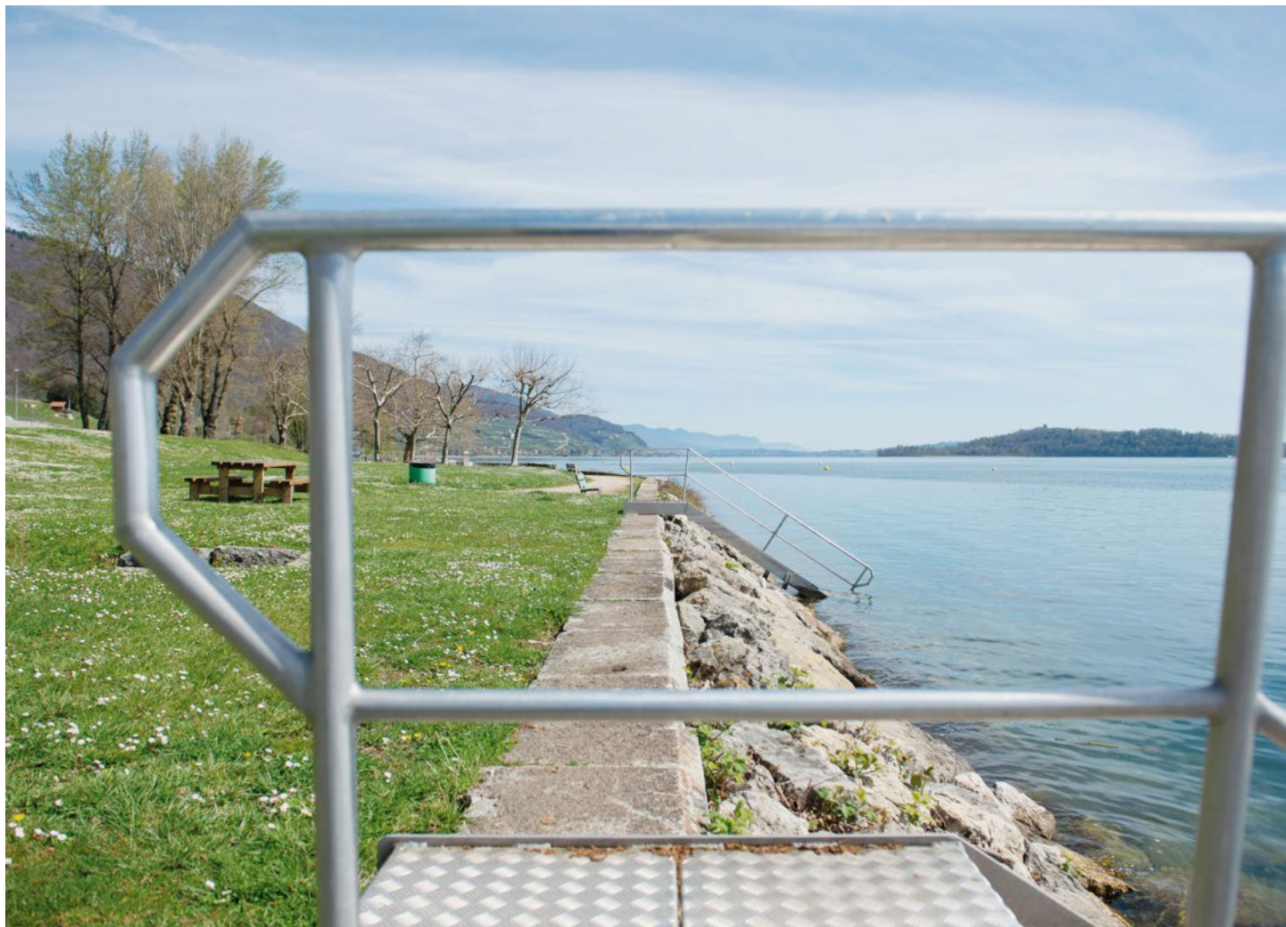
Des travaux de stabilisation de la berge ainsi que d'aménagement ont été réalisés à la plage de Saint-Joux. PETER SAMUEL JAGGI
