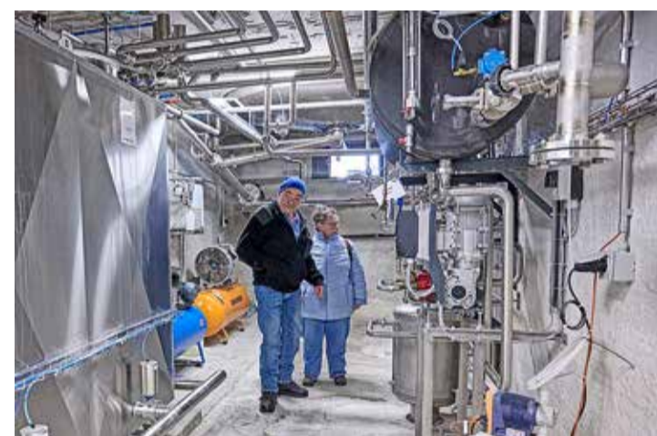
In sieben Monaten Bauzeit ist eine topmoderne Käserei entstanden.
